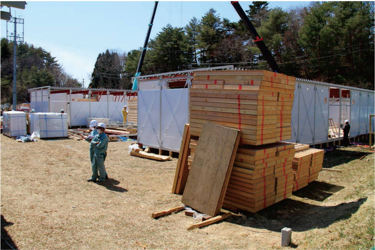
【愛宕地区に応急仮設住宅の建設が始まる】
