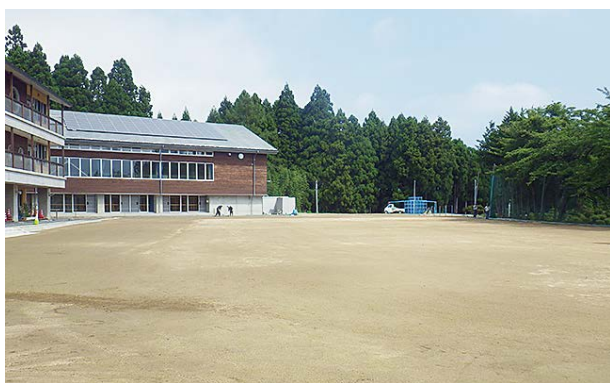
応急仮設住宅が撤去され復旧した重茂小グラウンド(令和元年8月)
