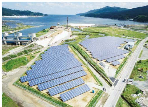
津軽石発電所
