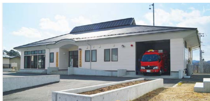
第30分団屯所及び格納されている消防ポンプ車 (平成28年3月完成)
