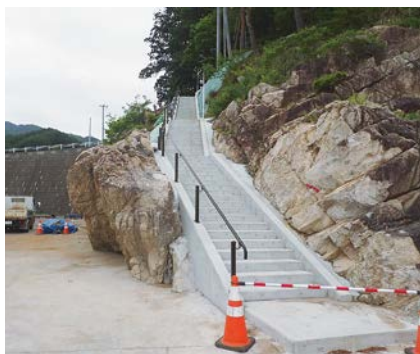
完成した石浜地区の津波避難路(令和元年6月)
