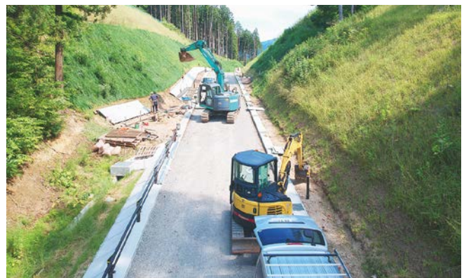
整備が進む河南高浜線 (令和元年7月)
