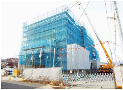
建設工事が進む藤原雨水ポンプ場 (令和2年1月)
