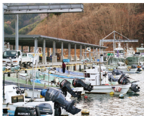
復旧が進む重茂漁港
