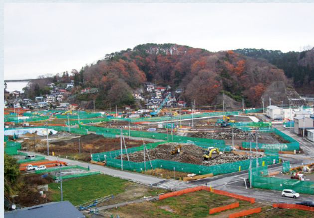
土地区画整理事業による整地が進む鎌ヶ崎地区
