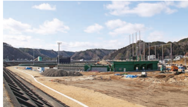
復旧工事中の田老野球場 (平成 28 年 2 月)
