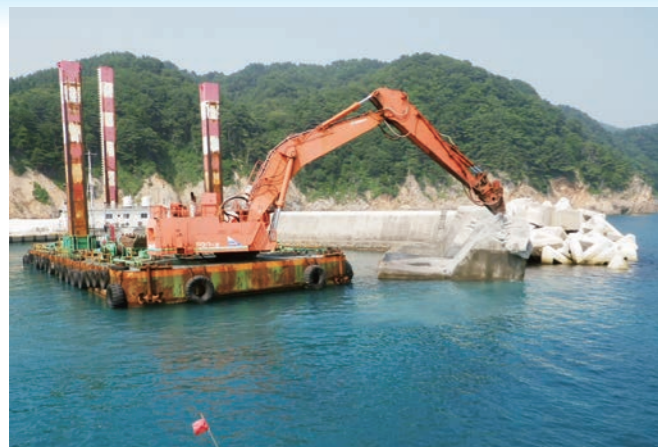
復旧工事中の千鷲漁港 (平成 26 年 7 月)
