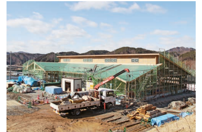
復旧工事中の田老診療所
