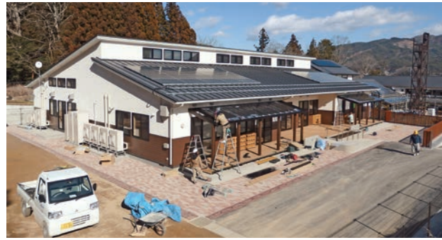
復旧工事中の津軽石保育所 (平成 28 年 2 月)
