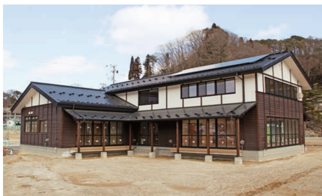
復旧工事中の楸ヶ崎公民館 (平成 28 年 2 月)
