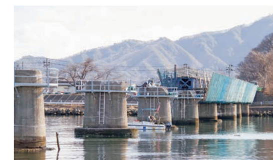
復旧工事中のJR山田線伊川橋りょう (平成28年1月)
