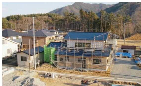
宅地完成し、住宅の建設が進む重茂地区 (平成28年2月)
