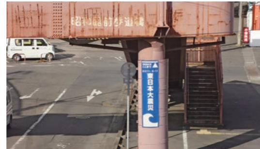
市役所前の歩道橋に設置された浸水表示板
