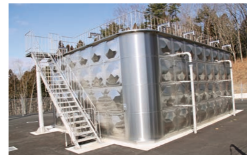
整備が完了した三王団地の配水池
