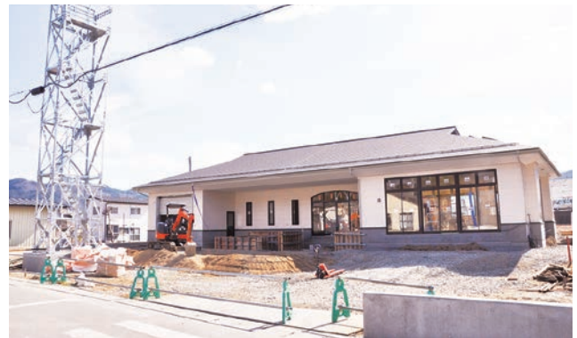
完成間近の高浜地区センター（平成29年3月）
