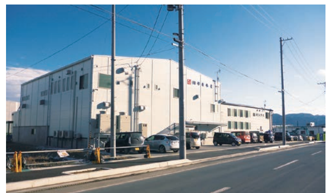
整備が進む鯉ヶ崎地区の水産加工流通施設
