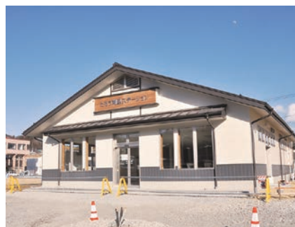
道の駅たろうに建設中のたろう潮里ステーション (平成29年3月)
