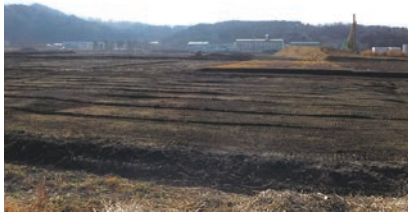
津軽石・赤前地区のほ場整備の様子(平成28年12月)
