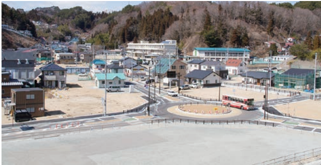
住宅の建設が進む鎌ヶ崎地区 (平成29年3月)
