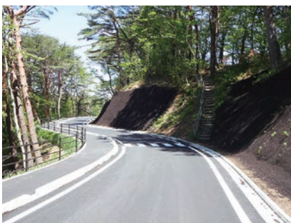
整備された浄土ヶ浜園地内道路 (平成28年5月)
