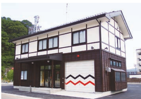
整備された鉾ヶ崎地区の第6分団屯所 (平成28年7月)
