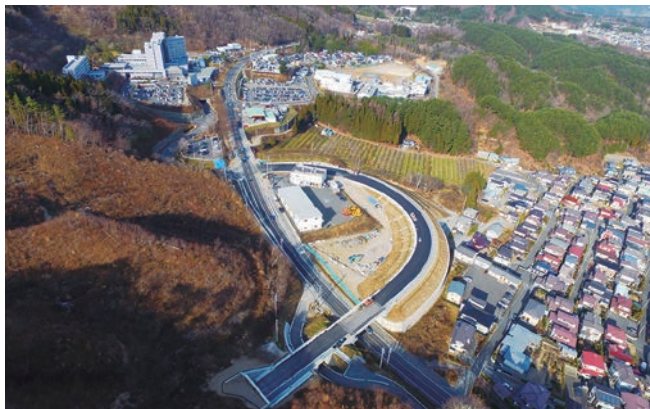
北部環状線（山口～佐原間（佐原橋））（平成 28 年 12 月）
