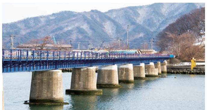
復旧が進むJR山田線閉伊川橋りょう
