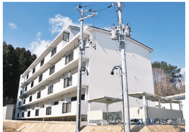
完成した山口災害住宅
