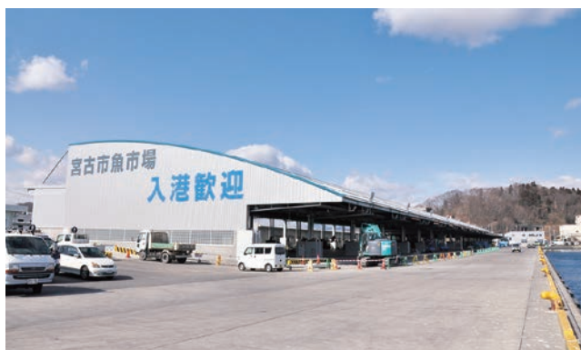
増築工事中の宮古市魚市場
