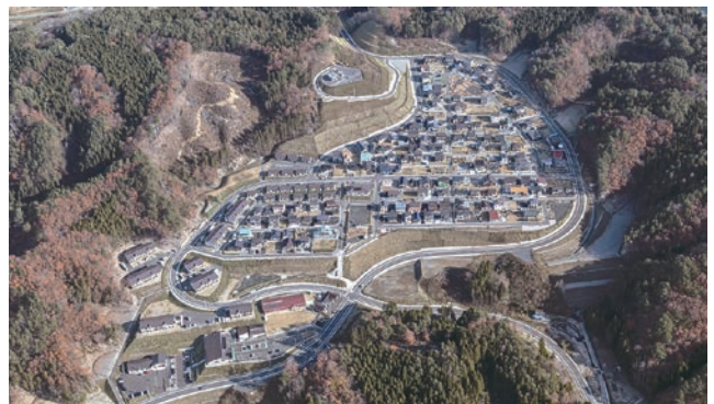
住宅の建設が進む田老地区三王団地 (平成29年1月)
