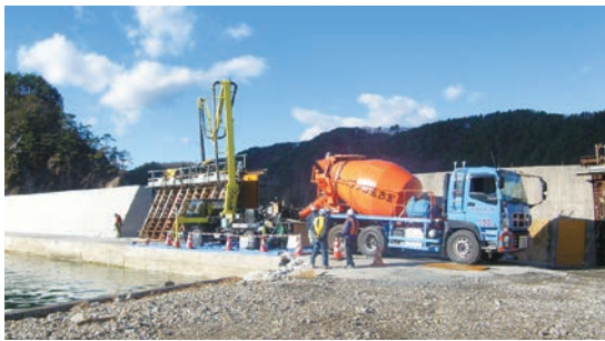
復旧工事が進む宿漁港の様子 (平成 28 年 12 月)
