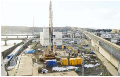
杭工事が進む新川町ポンプ場 (平成31年1月)
