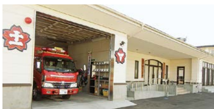
第11分団屯所及び格納されている消防ポンプ車 (平成31年1月)
