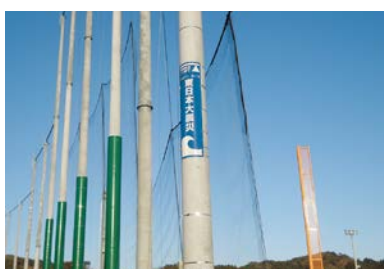
田老野球場に設置されている浸水表示板 (平成31年1月)
