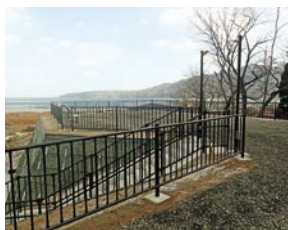
完成した磯鶏地区の津波避難路と津波避難場所 (平成31年2月)
