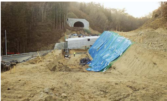
北部環状線で整備が進む近内復興トンネル付近 (平成31年1月)
