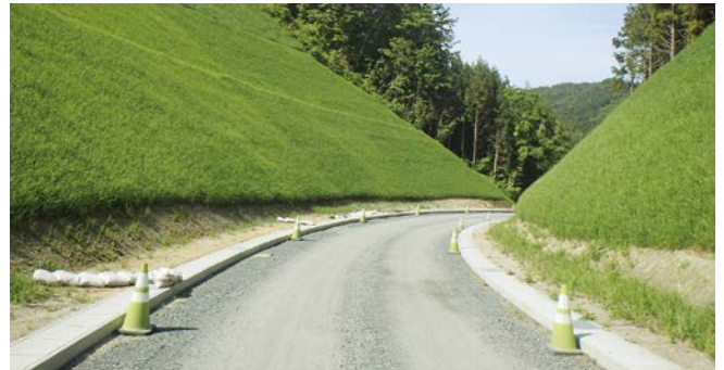
整備が進む河南高浜線 (平成31年1月)
