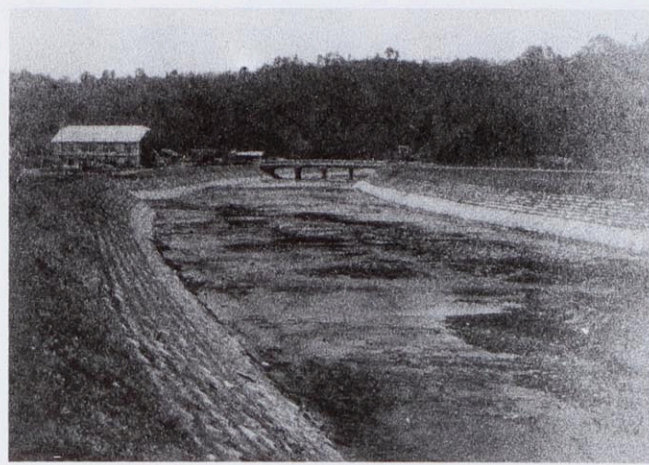
改修された長内川護岸
