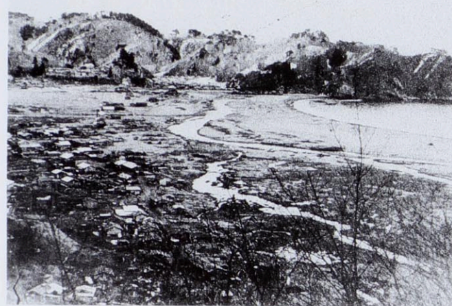
防浪堤工事着工前の田老=昭和9年2月
