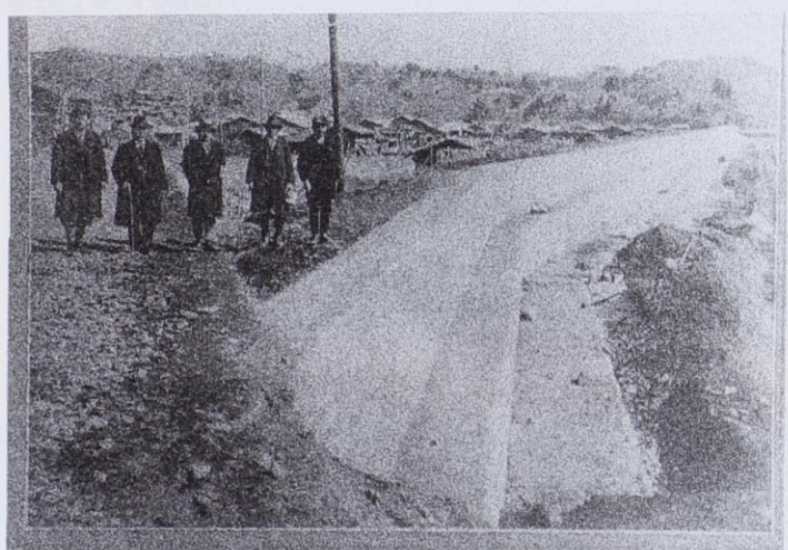
工事が進む防浪堤
