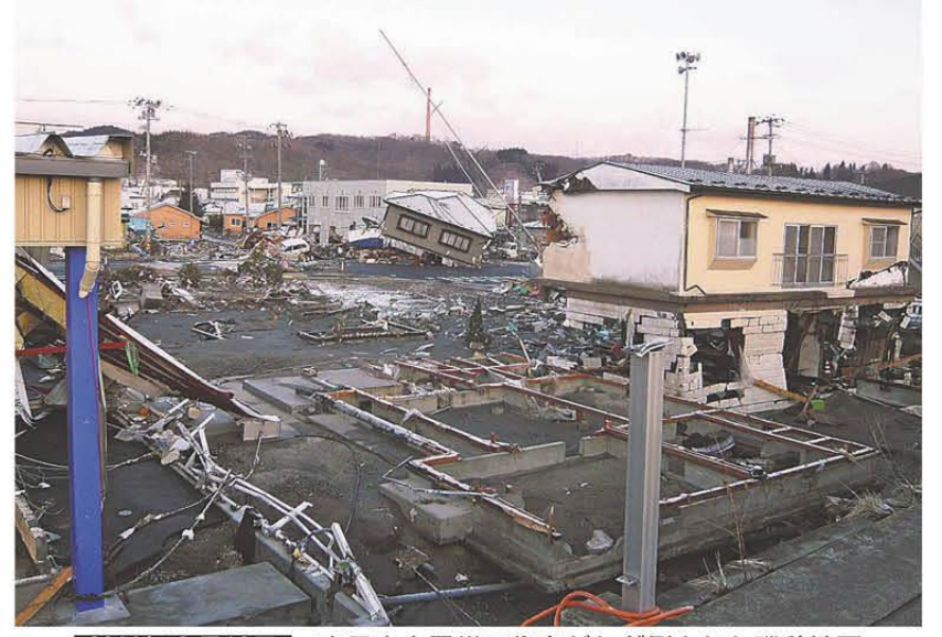
2011年3月12日 東日本大震災で住宅がなぎ倒された磯鶏地区
