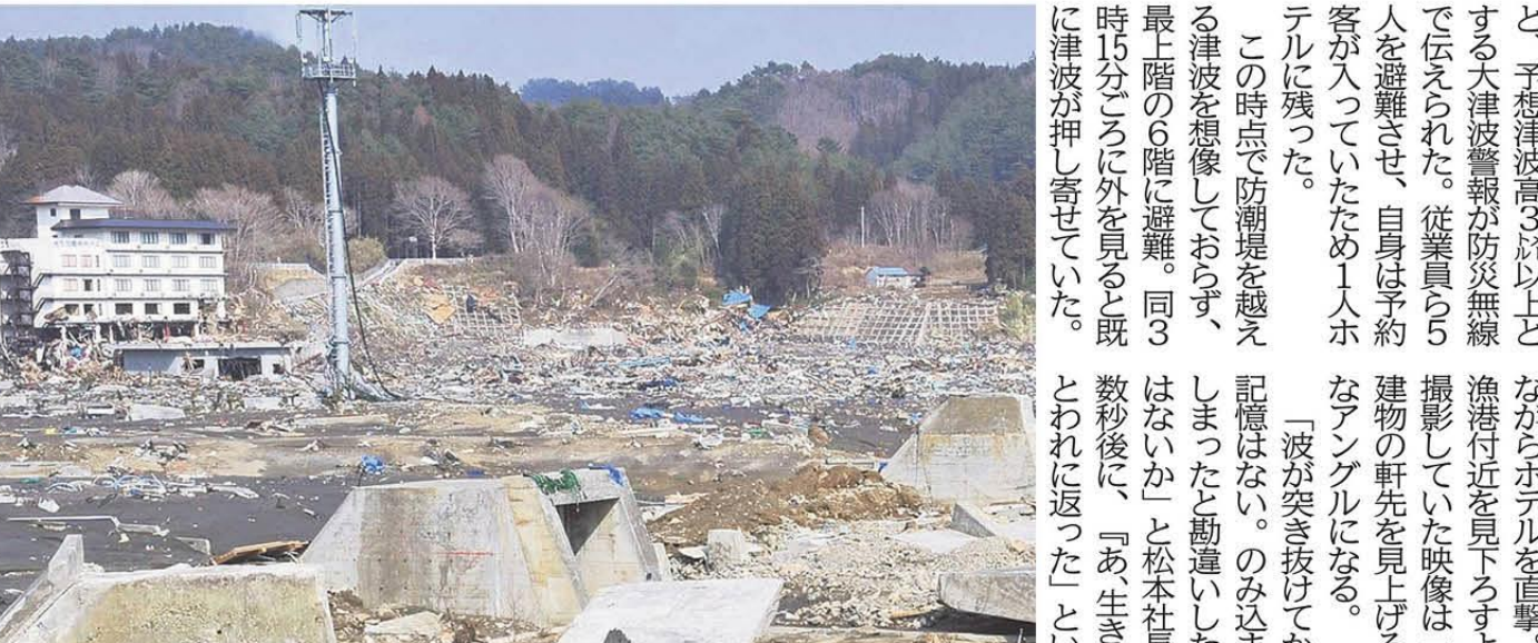
高さ10mの防潮堤が倒され、壊滅的な被害を受けたたろう観光ホテル周辺＝2011年3月13日
