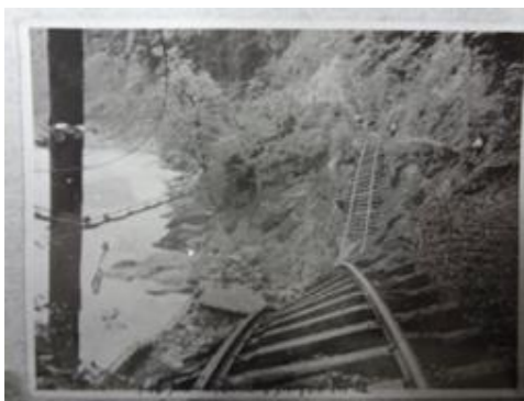
昭和23年9月 アイオン台風 線路崩壊 (川井村・山田線)
