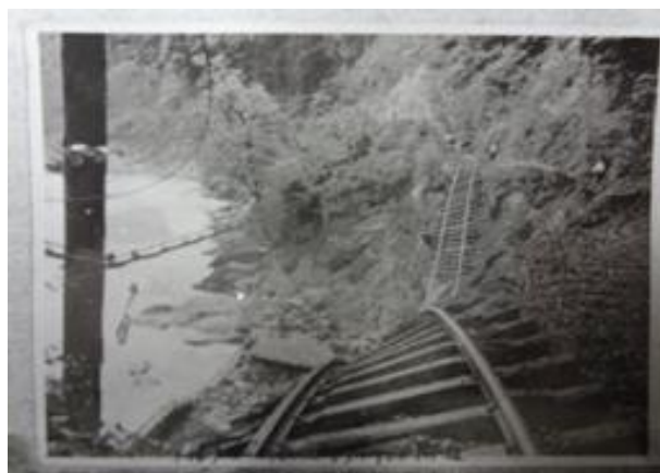
昭和23年9月アイオン台風 (川井村・山田線)線路崩壊
