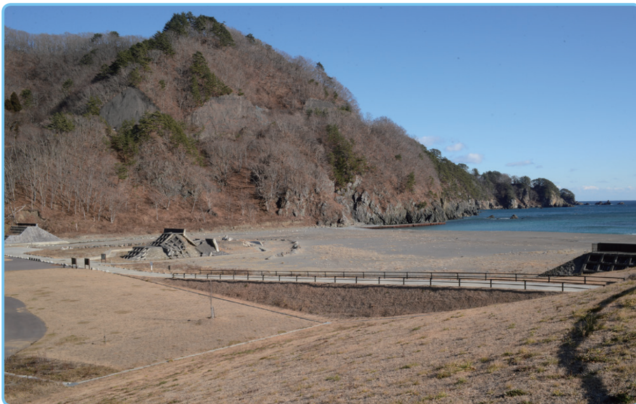
つなみのこわさをつたえるためにのこされた、こわれた防潮堤
