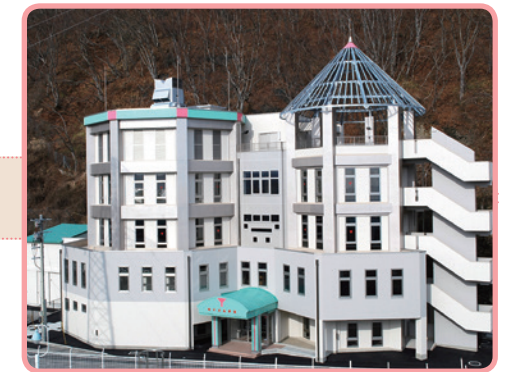
新しくなった、5階建ての久慈地下水族科学館もぐらんぴあ
