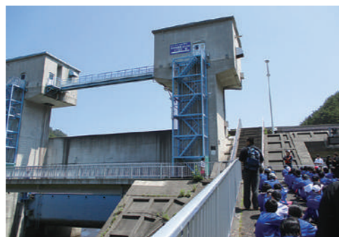
東日本大震災の津波から村を守った「普代水門」
