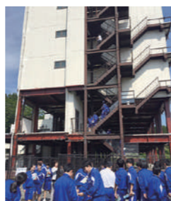
東日本大震災の津波で1、2階の フロアが抜けた「たろう観光ホテル」
