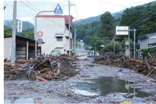
台風上陸の翌朝、国道455号岩泉橋付近
