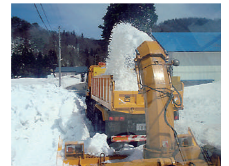
除雪作業の様子
