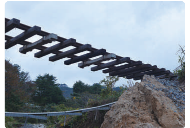
台風の被害で宙にういてしまった線路 山田町船越地区
