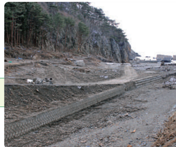
被災後(2011(平成23)年3月23日)
