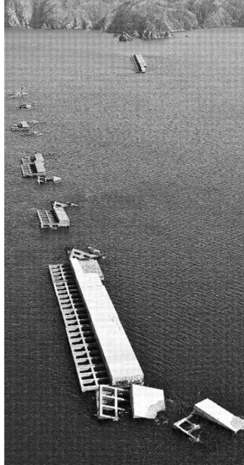
津波で破壊された釜石港の防波堤――
