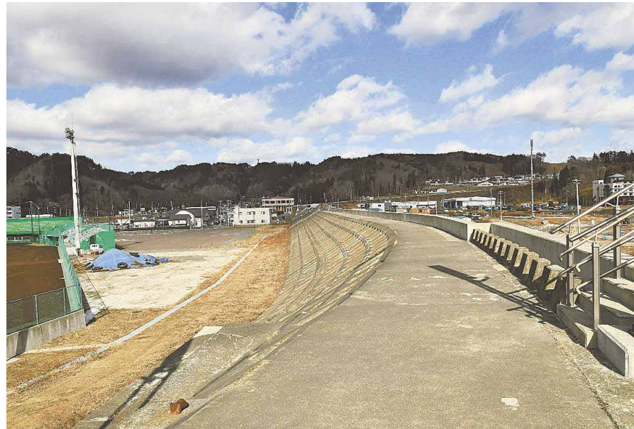
21年2月9日 防潮堤左奥の道の駅エリアは台風19号豪雨で被災したが、復旧した
