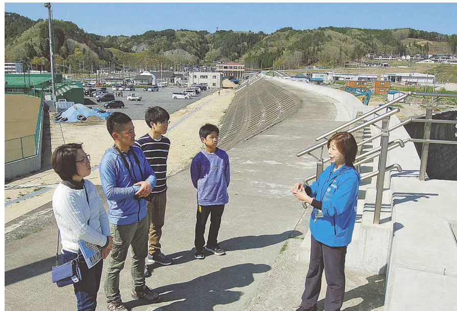
17年5月3日 左手の土地区画整理エリアは野球場や観光案内施設が完成。右奥の三王団地では住居の建設が進む
