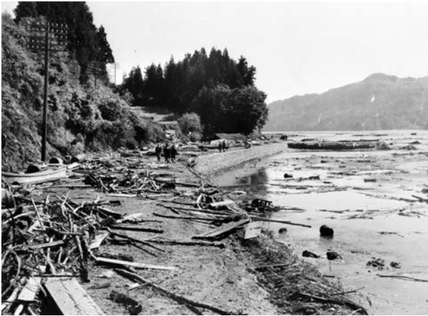
【写真 60】高浜 県道（現国道 45 号）〔宮古測候所〕
