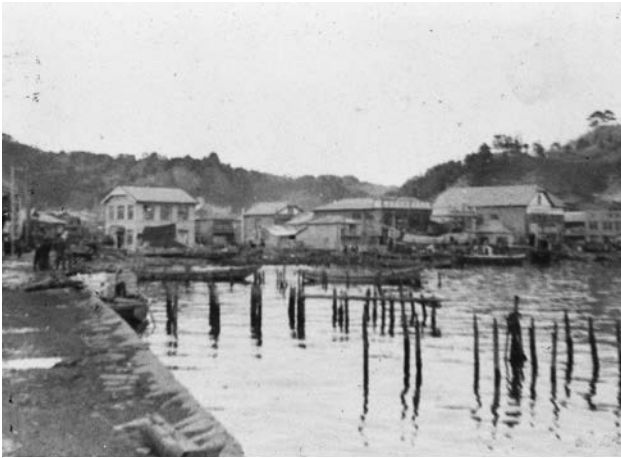
【写真 32】 宮古町 鉾ヶ崎 海岸通岸壁の棧橋板敷きは流され杭だけが残った [箱石・久里]
