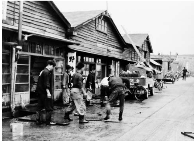
【写真55】（向町）[宮古測候所]
