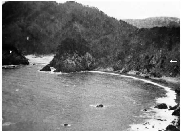
【写真 45】重茂村里 津浪はこの付近の海崖では比較的高く、→で示した程度の浸水があった [東京帝国大学地震研究所]
