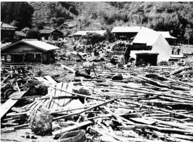
【写真 62】高浜 中心地の惨状〔宮古測候所〕
