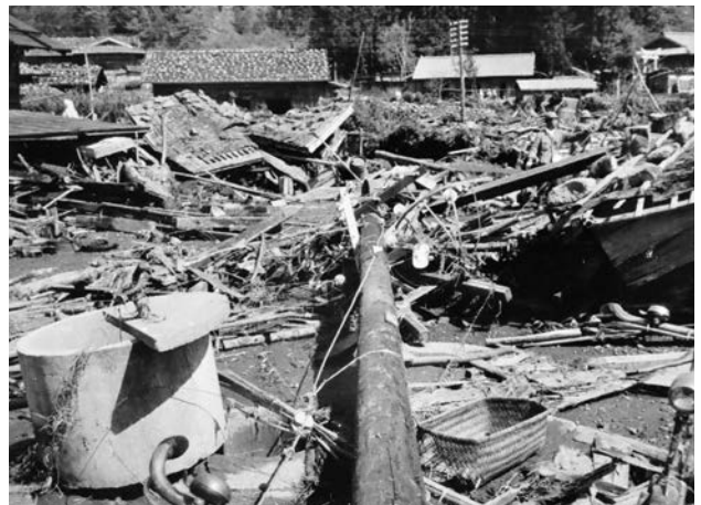
【写真 61】高浜（倒れた電柱）〔宮古測候所〕
