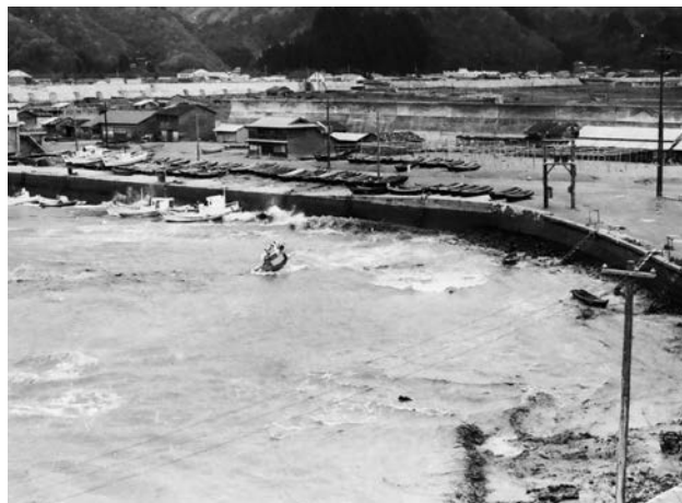
【写真 71】（田老漁港 引き波）[宮古測候所]
