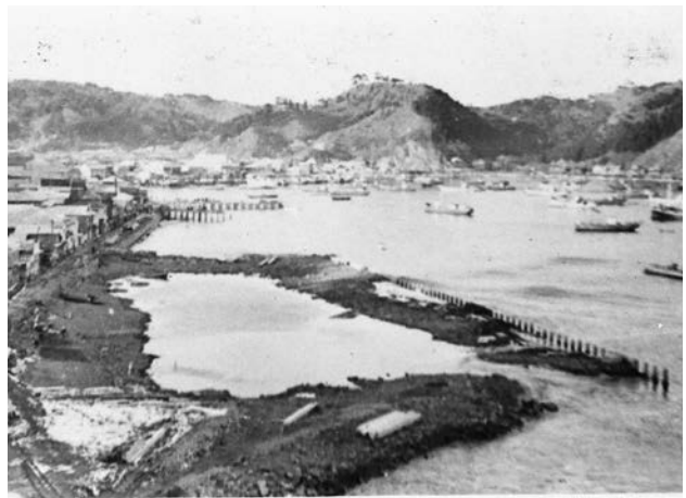
【写真 33】 宮古町 鉾ヶ崎上町 海岸通は（出崎埠頭）埋立て工事のため、人家の被害を少なからしめた [箱石・久里]
