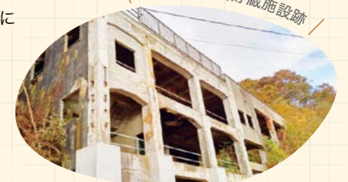
鉄ヶ崎の鉱石貯蔵施設跡
